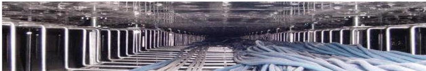
Se tiene la creencia de que debajo del piso falso, en el espacio utilizado para la distribución de aire de enfriamiento, sólo se permite la instalación de cable tipo plenum; pero en realidad hay otros cables no plenum aprobados para esta aplicación; esto por supuesto, siempre en total apego a los reglamentos y normas locales.
